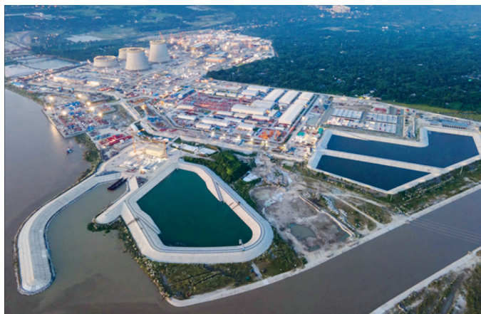
Рис. 4. Водозаборное сооружение АЭС «Руппур» (Фото заимствовано из открытых источников Интернета)
