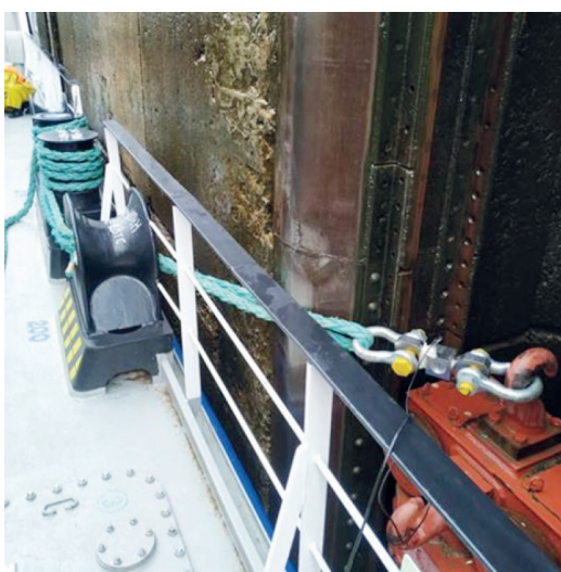
Рис. 3. Вид установленного тензодатчика в разрез швартовного каната
