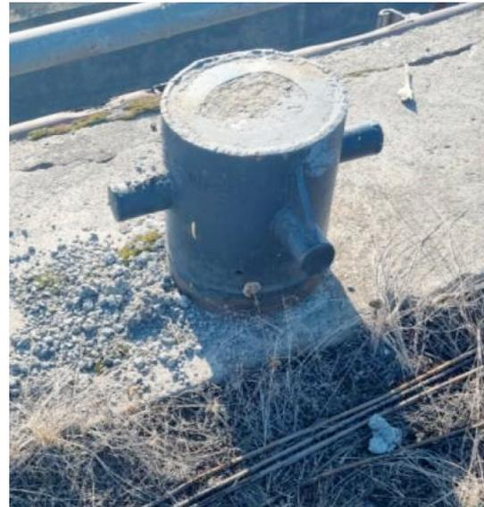
Рис. 5. Нетиповой швартовый кнехт железобетонного причала с подкрановыми и железнодорожными путями
