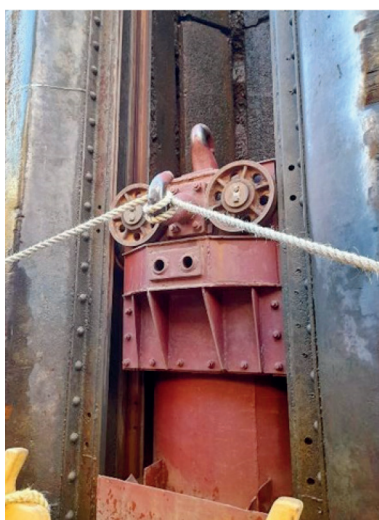
Рис. 2. Плавающий рым в камере шлюза (Заимствовано из общедоступных ресурсов интернета)
