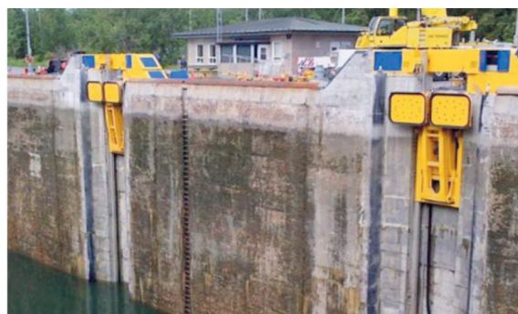
Рис. 6. Общий вид эксплуатируемых вакуумных автошвартовных устройств на шлюзах Уэллендского канала в Канаде и США:
