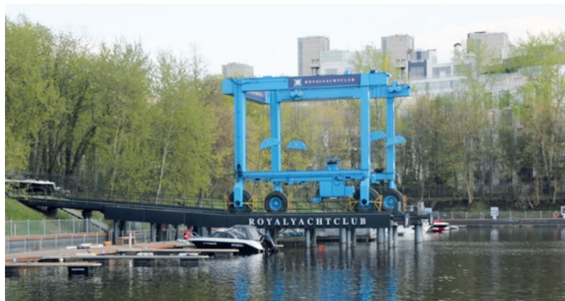
Рис. 5. Судоподъемное сооружение «Кран ВНТ-100» с приводом на четыре колеса
