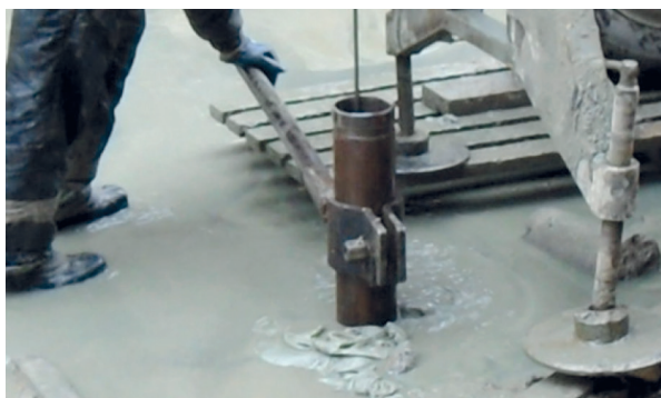
Рис. 4. Излив водно-грунтовой пульпы из скважины при бурении (фото автора)
