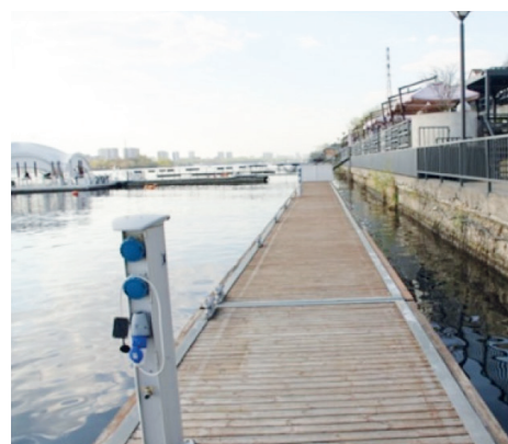
Рис. 4. Типы причальных сооружений яхт-клуба Royal Yacht Club: а — плавучий причал со швартовными пальцами; б — плавуче-стоечный причал
