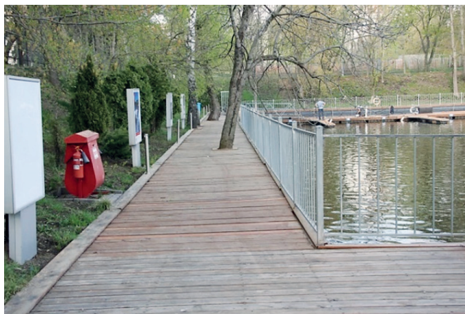
Рис. 7. Пешеходная эстакада (променад) поверху берегоукрепления
