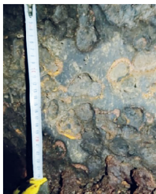
Рис. 3. Примеры язвенной коррозии на элементах ворот (а) и затворах (б) судоходных шлюзов
