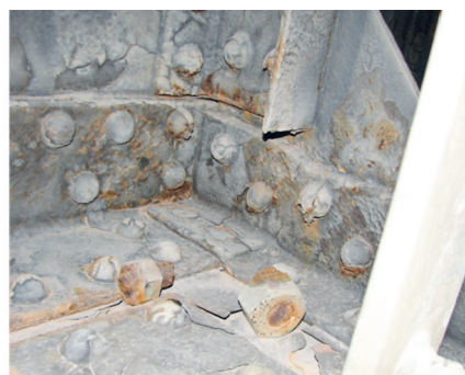
Рис. 5. Примеры состояния защитного покрытия на элементах двустворчатых ворот на одном из шлюзов, расположенном на Морском пути Святого Лаврентия после 40 лет эксплуатации: а — виниловое покрытие; б — эпоксидно-каменноугольная эмаль
