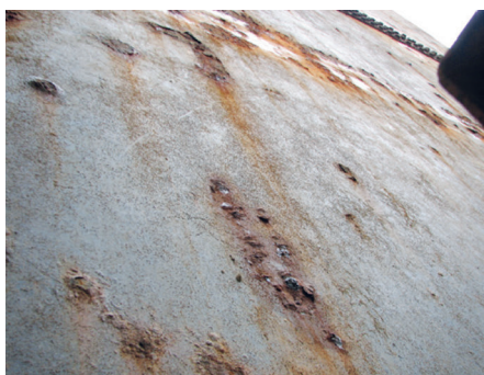
Рис. 5. Примеры состояния защитного покрытия на элементах двустворчатых ворот на одном из шлюзов, расположенном на Морском пути Святого Лаврентия после 40 лет эксплуатации: а — виниловое покрытие; б — эпоксидно-каменноугольная эмаль
