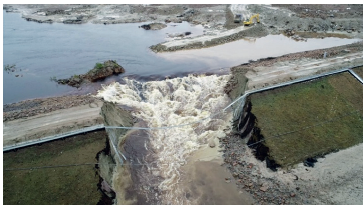
Рис. 6. Прорыв плотины Белопорожской МГЭС-2 24 октября 2020 г. (Фото заимствовано из открытых источников Интернета)
