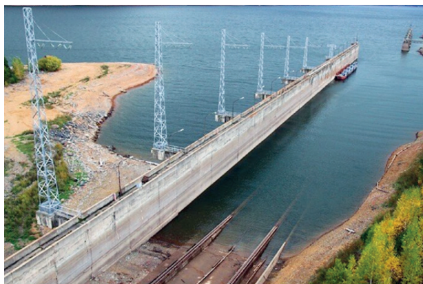
Рис. 1. Волнозащитная стенка верхнего бьефа Красноярского гидроузла (Фото заимствовано из открытых источников Интернета)
