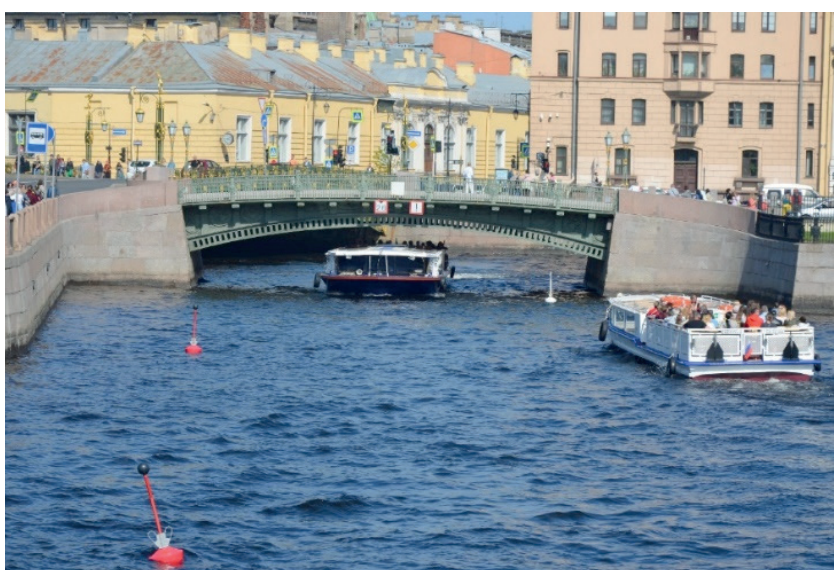
Рис. 3. Первый Инженерный мост с металлическим нижним поясом арочного вида (фото из личного архива авторов)
