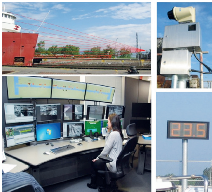
Рис. 7. Система позиционирования судна в камере шлюза для обеспечения автошвартовки (Заимствовано из общедоступных ресурсов интернета)
