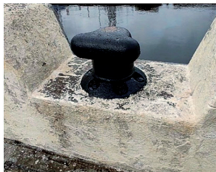
Рис. 1. Неподвижное швартовное устройство в виде швартовной тумбы:
