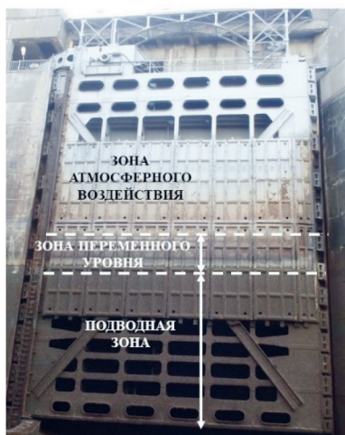
Рис. 2. Зонирование воздействия коррозионной среды на примере эксплуатируемых двустворчатых ворот с безнапорной (а) и напорной (б) сторон
