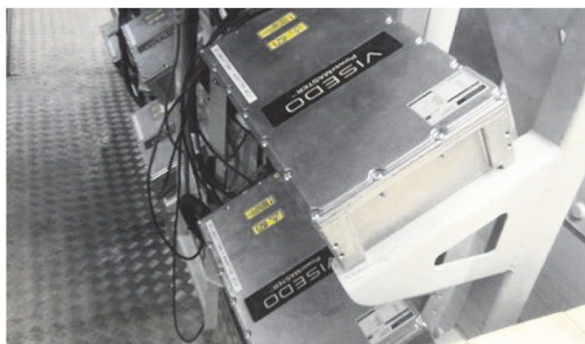
Рис. 6. Внешний вид главного распределительного щита постоянного тока (а) и полупроводниковые модули выпрямитель — инвертор (б)
