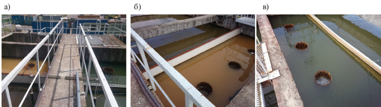
Рис. 3. Фотографии очистных сооружений, наглядно показывающие качество входной и выходной воды: а – слева конец первой емкости – место забора сточной воды, справа выход из очистных сооружений; б – исходная вода; в – очищенная вода
